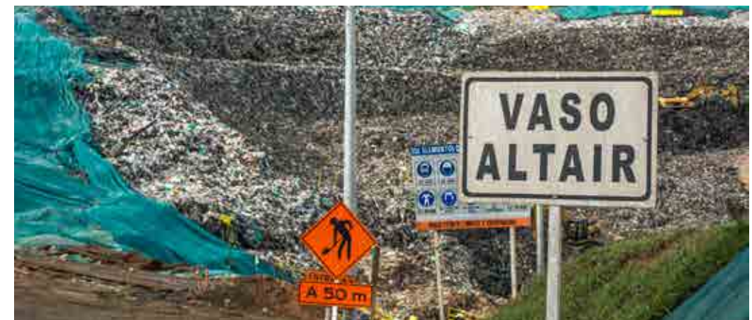
Figura 34 Señalización de vías del relleno
