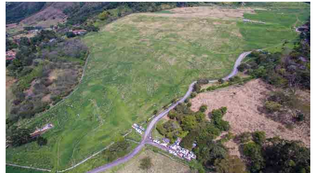
Figura 13 Relleno Sanitario Curva de Rodas
