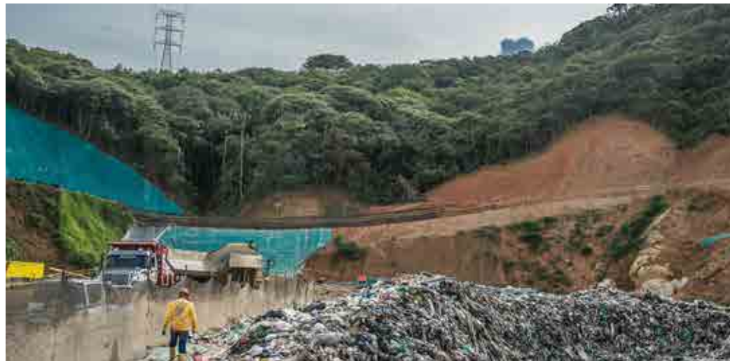
Figura 32 Instalación de geomembrana en la adecuación del vaso Altaír, fases 3 y 4
