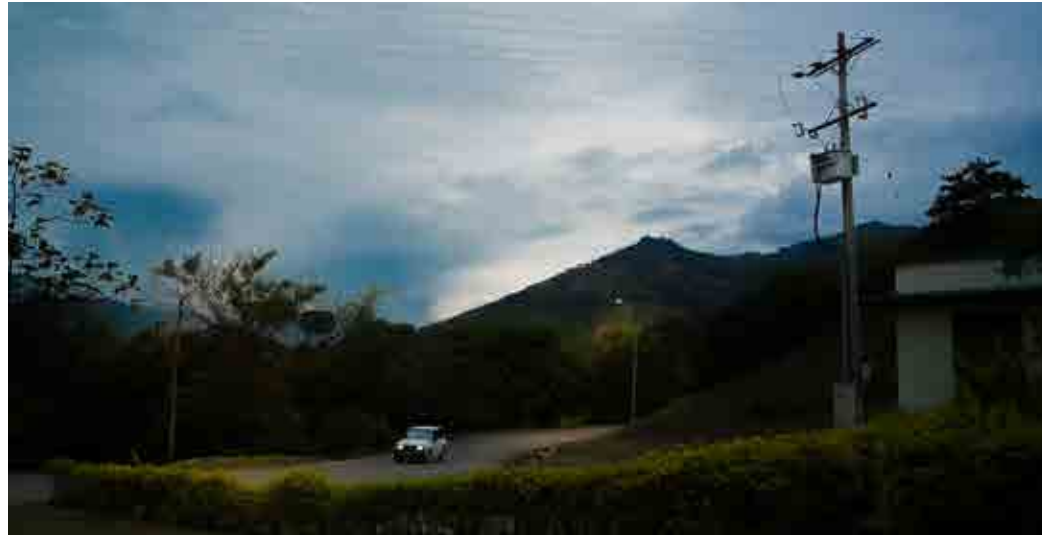
Figura 35 Instalación de red de iluminación en el Relleno Sanitario La Pradera
