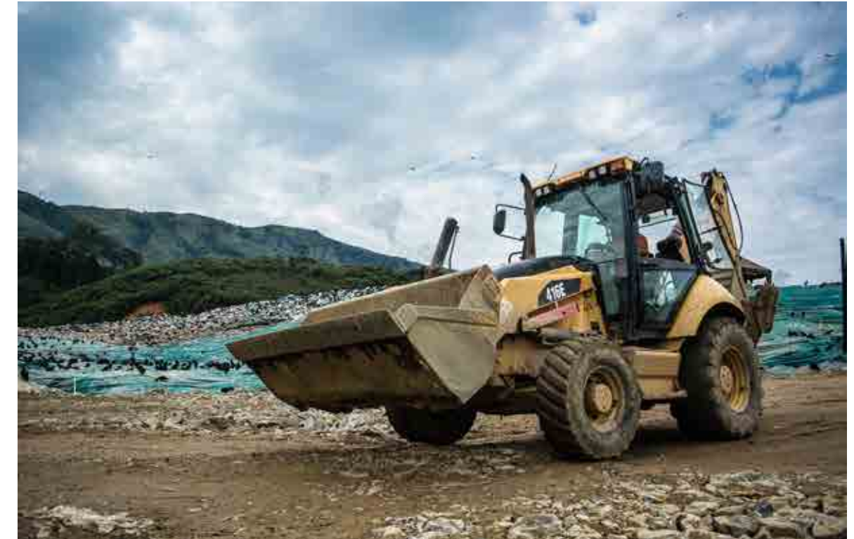
Figura 26 Maquinaria utilizada en el relleno sanitario para labores de disposición final
