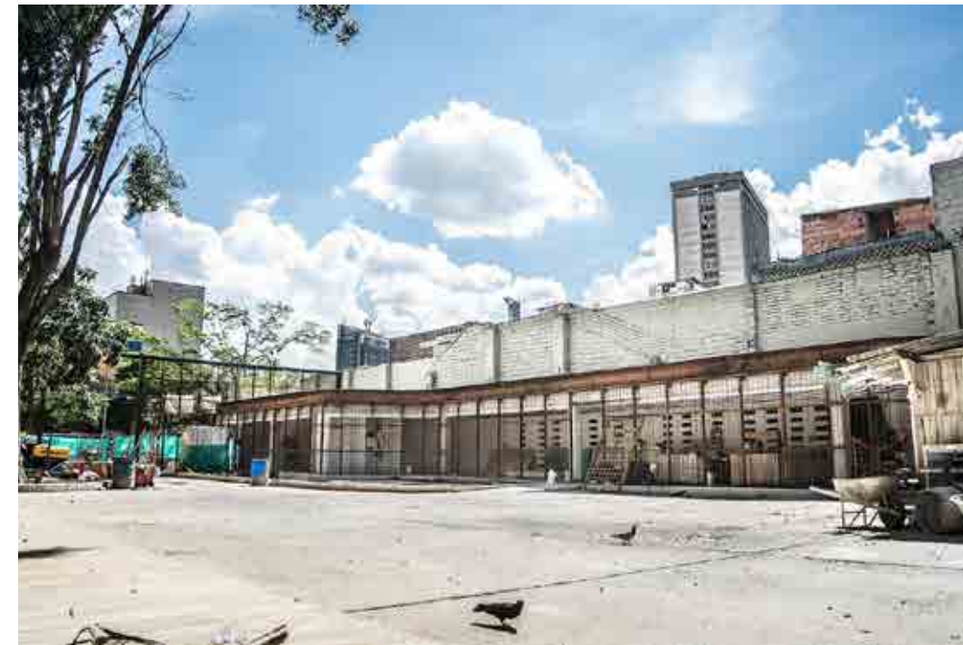
Figura 39 Estado de la obra, mes de diciembre de 2016
