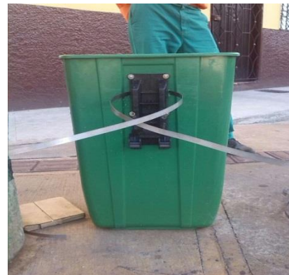
Instalación del zuncho para fijación de la cesta en el poste
